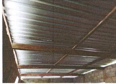
Foto 14: Cubierta de lámina de bodega sustituido.
